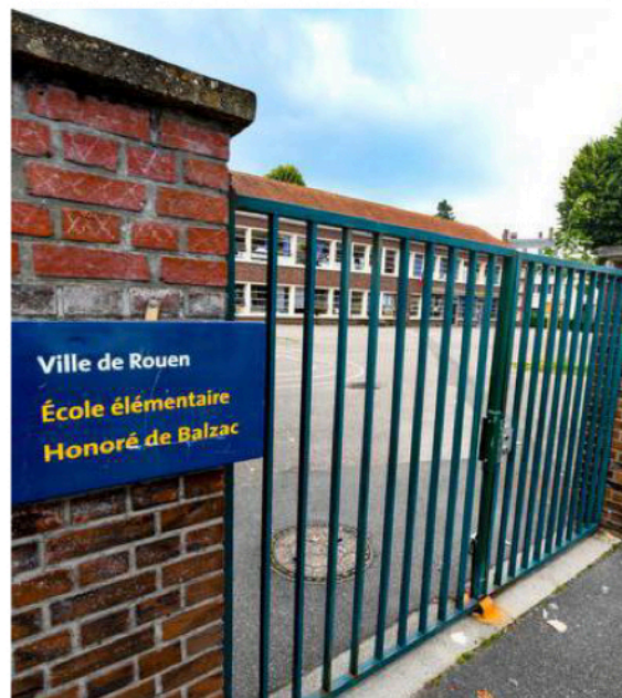
Les analyses de l'enquête environnementale ont démontré la présence de plomb au sein de l'école Honoré-de-Balzac, dans le quartier Grammont à Rouen (photo BORIS MASLARD)
